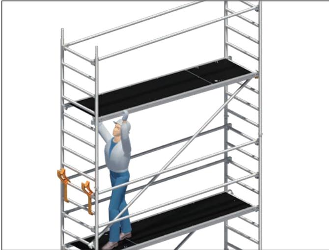
4. Diagonalen 20 und Durchstiegsbrücke 25 einsetzen. Die Diagonalen müssen auf beiden Seiten turmartig (Zick-zack-Form) eingebaut werden.
