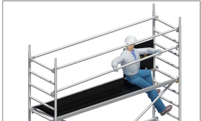
3. In der Durchstiegsöffnung sitzend, erfolgt die Demontage der Zwischengeländer, hierzu werden die bereits unter 2. einseitig gelösten und aufgelegten Geländer 17 auf der Seite der Durchstiegsklappe ausgehoben.
